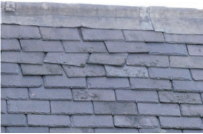
Scheefgewaaide, uitzakkende leien en beschadigd noklood (© Joan van den Hurk)
