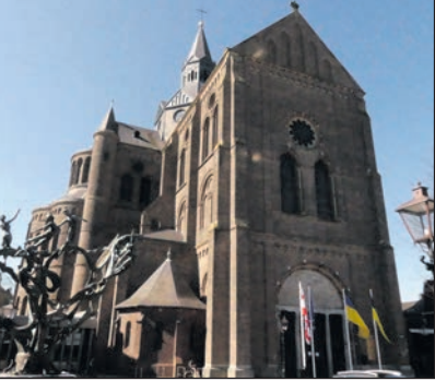
Voorzijde van de Petruskerk, de leien op – onder andere – het dak van het traptorentje en van het transept worden vervangen (© Joan van den Hurk)
